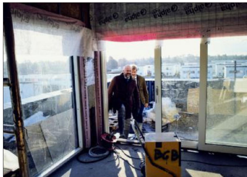
De sidste lejligheder i Trylleskov Strand forventes at stå færdige i 2021. Foto: Thomas Nielsen
